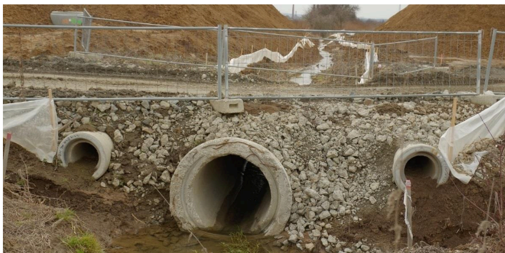
Obrázek 26: Příklad křížení vodoteče s provizorní přístupovou komunikací – propustky pro suchou a mokrou cestu v kombinaci s dočasnými naváděcími zábranami. Dálnice D1, úsek 0137.
