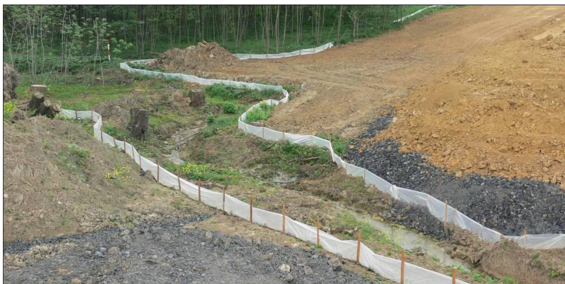
Obrázek 24: Dočasné bariéry proti vnikání obojživelníků do prostoru staveniště (Zdroj: ekodozor HBH Projekt spol. s r.o. – dálnice D47)
