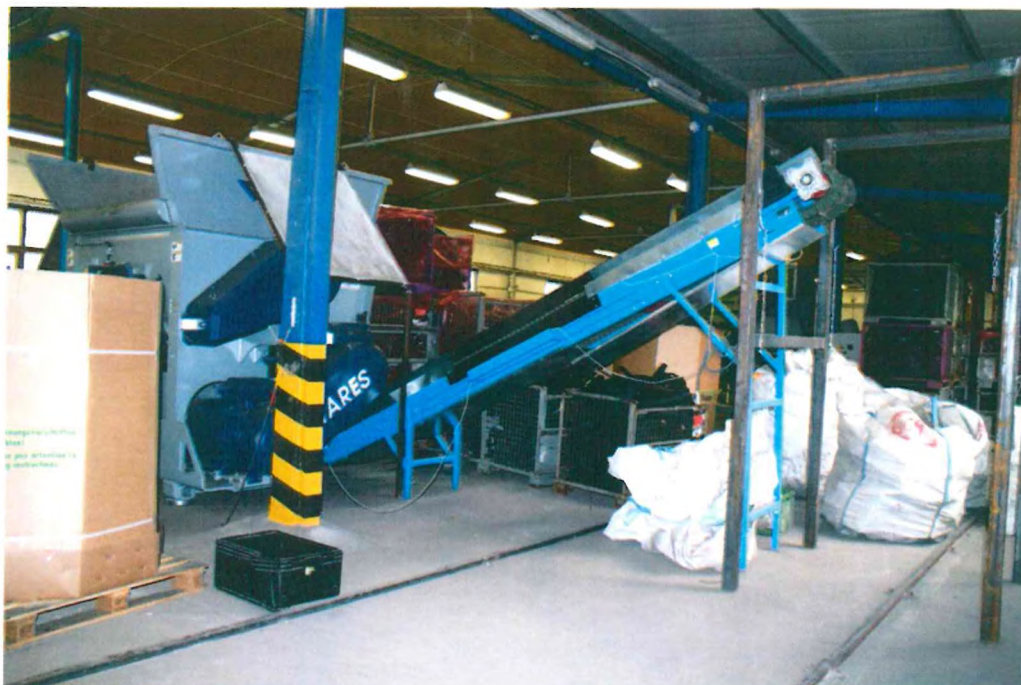
Obrázek č. 6 – Výrobní hala - drtič ANTARES s výstupním dopravníkem a konstrukcí pro uchycení big-bagů
